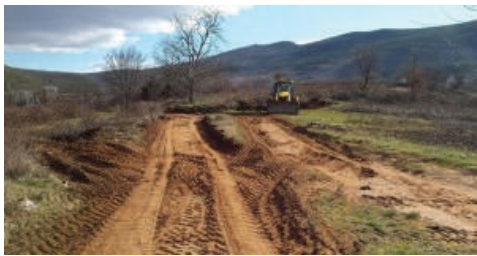
Caterpillar trabalhando na nova estrada entre o Centro de Mediugórie e a Colina das Aparições, onde surgirão calçadas pavimentadas e estrada asfaltada.
